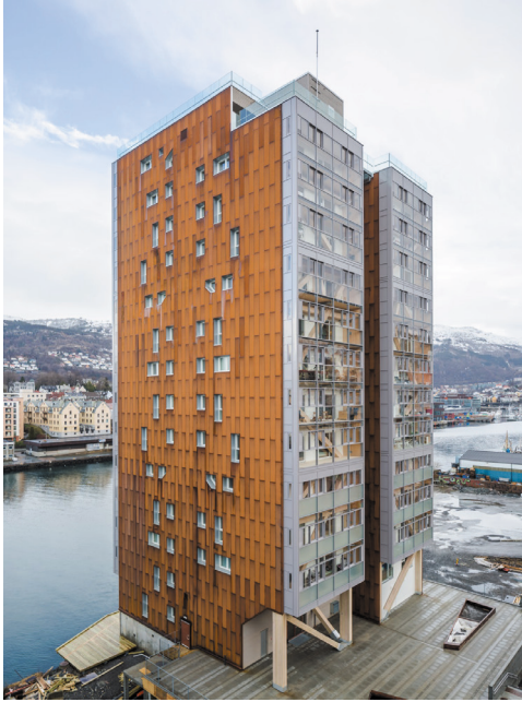
Eestlaste ehitatud maailma kõrgeim puidust kandekonstruktsioonidega korruselamu „Treet“ Norras.
